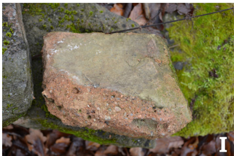
Obr. 6. G) pohled na vnější líc obvodové zdi jádra hradu v jeho východní části, H) pohled na vnitřní líc zdiva přístavby vysunuté do příkopu. I) doklad využití malty při zdění obvodové hradby jádra hradu (foto P. Drnovský, 2022). – Fig. 6. G) view of the outer side of the castle core's defensive wall in its eastern part, H) view of the inner face of the masonry of the extension projecting towards the ditch. I) evidence of the use of mortar in the construction of the defensive wall of the castle core (photos P. Drnovský, 2022).
